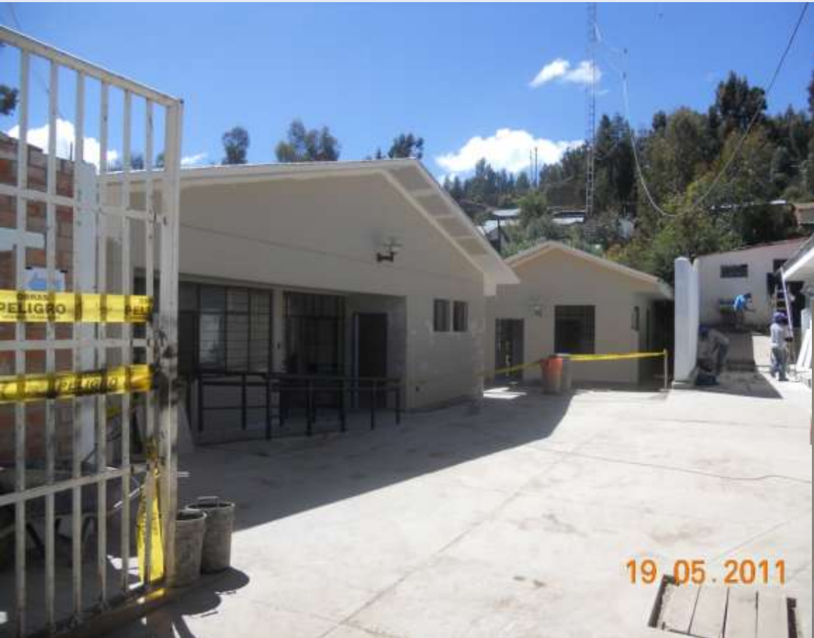
FOTO AL 19 DE MAYO Obra concluida, en proceso de recepción
